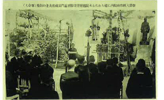
1935（昭和10）年10月に改築された大阪府病院（現・中津病院）【上】。敷地内に建てられた嘉門夫妻の等身大銅像【下】。「済生」1935（昭和10）年11月号
