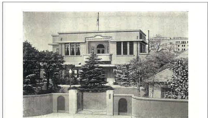
内務省の仮事務所となった済生会本部。大正4年築の建物は関東大震災で倒壊、その後、昭和7年7月に鉄筋コンクリート造りに生まれ変わった (済生会誌 (創立二十五周年誌)より)
